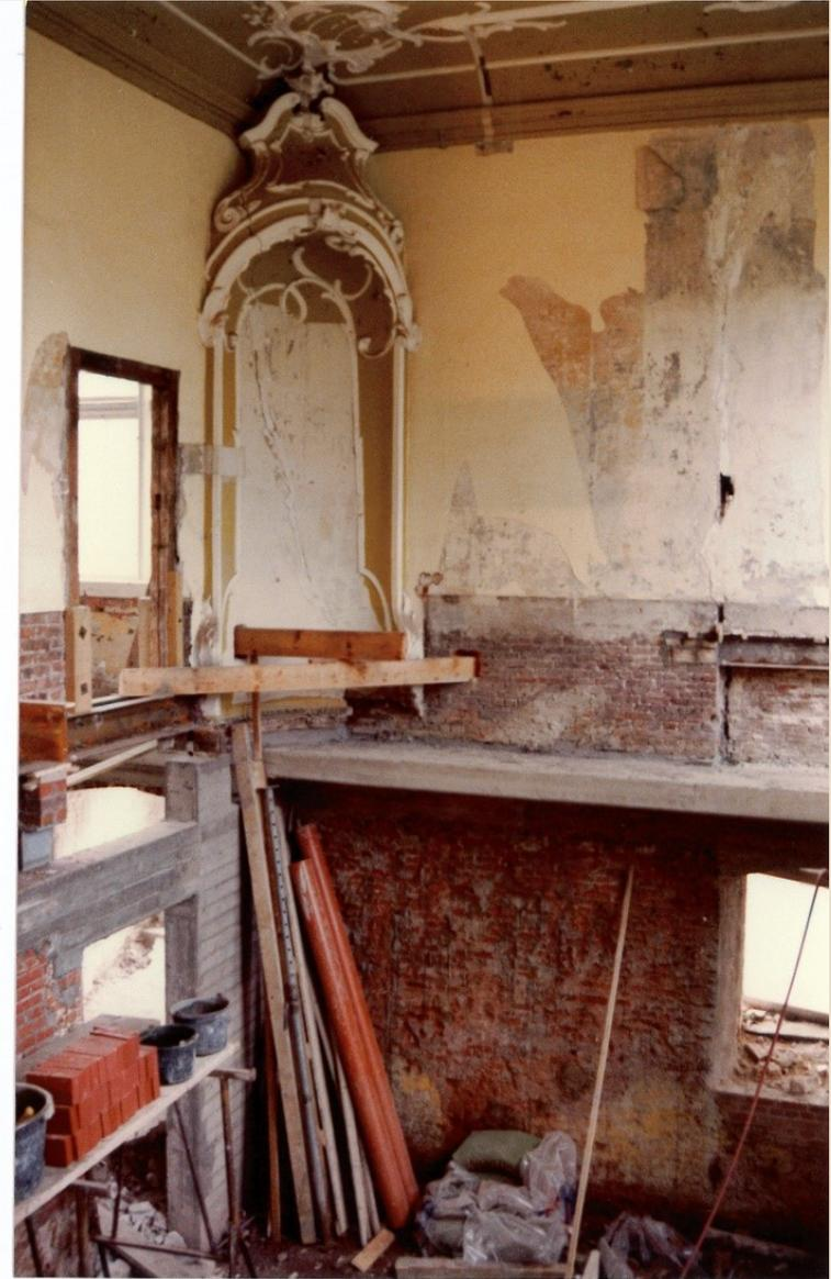
Bild Nr. 403 Ringbalken Mittelwand - Südost -
